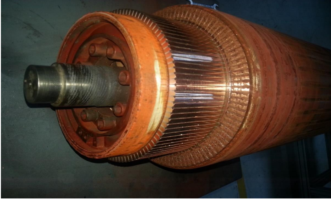
Şekil 3.7 Bakımları yapılan kollektor
