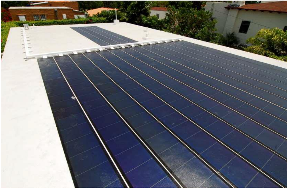
Şekil 4. 4 İnce Film Panel Çatı Uygulaması
