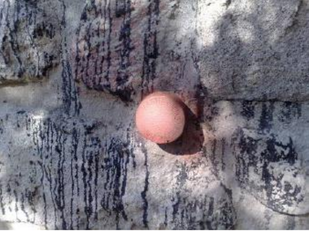
Nivelman duvar noktası
