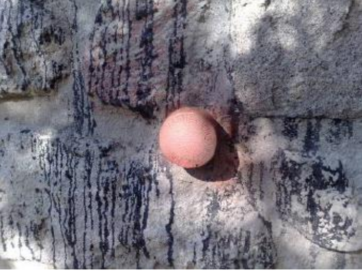
Nivelman duvar noktası
